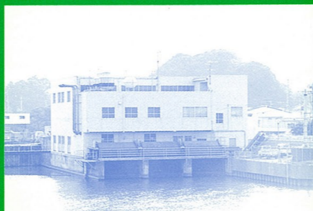
紀伊水道高潮対策工事 打桶川排水機場[徳島県]
