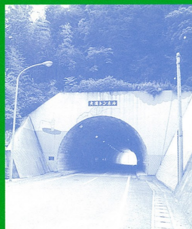
緊急地方道路整備工事 大滝トンネル[徳島県]
