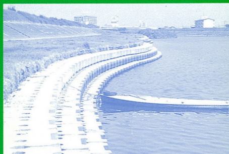
横見護岸復旧工事[建設省]
