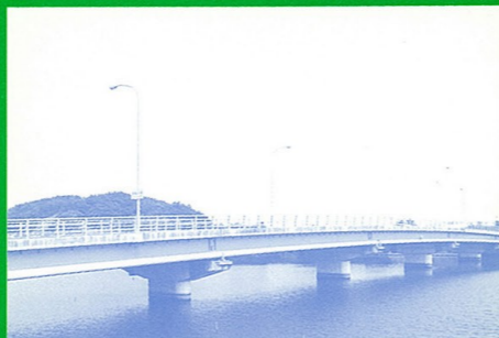
答島大橋新設工事[徳島県]
